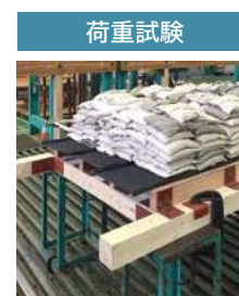
荷重試験 T・ルーフに砂袋で荷重をかけ荷重試験を実施。
