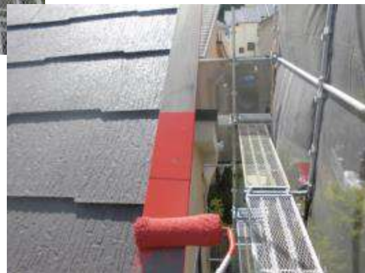
コロニアル周辺板金錆止め塗装→
